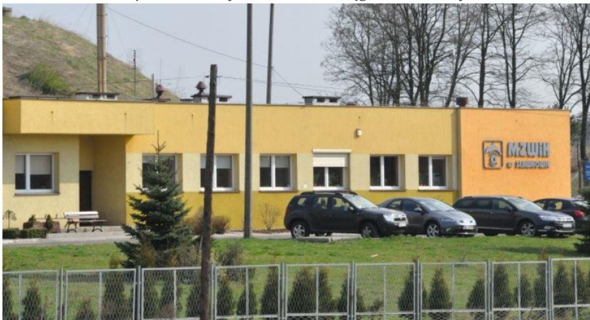
Rysunek 17. Miejski Zakład Wodociągów i Kanalizacji
