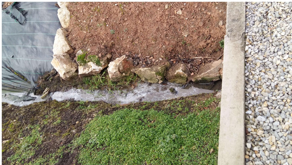
Rysunek 22 Kontrola na ulicy Krakowskiej – nielegalny zrzut ścieków do rowu
