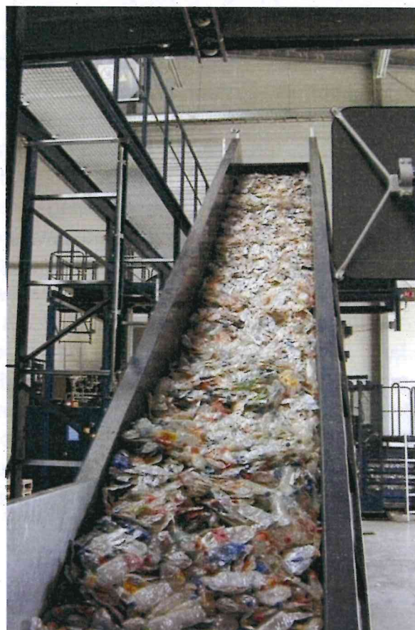
Foto. 2. RIPOK – Lipówka II w Dąbrowie Górniczej – instalacja do sortowania
