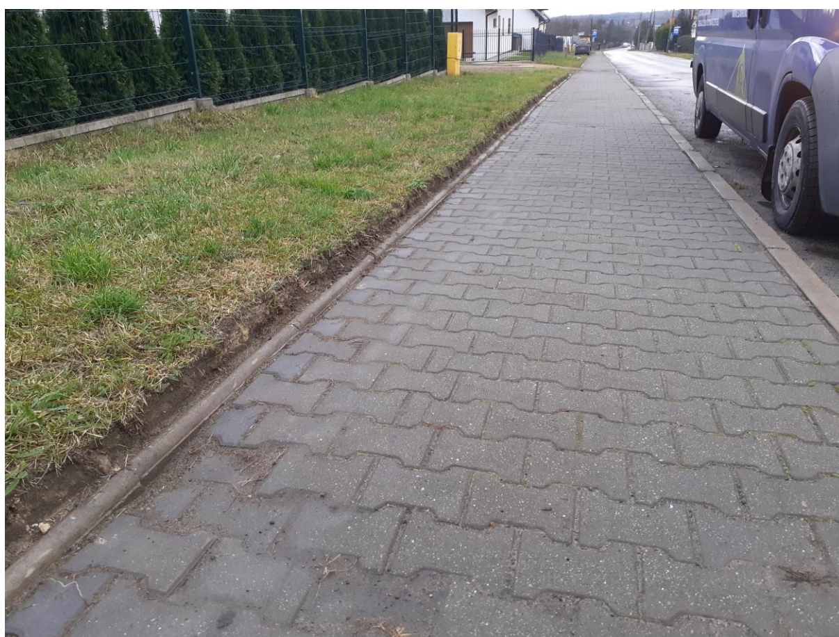
Rysunek 9. Prace porządkowe przy ciągach pieszych – ul. Obr. Westerplatte
