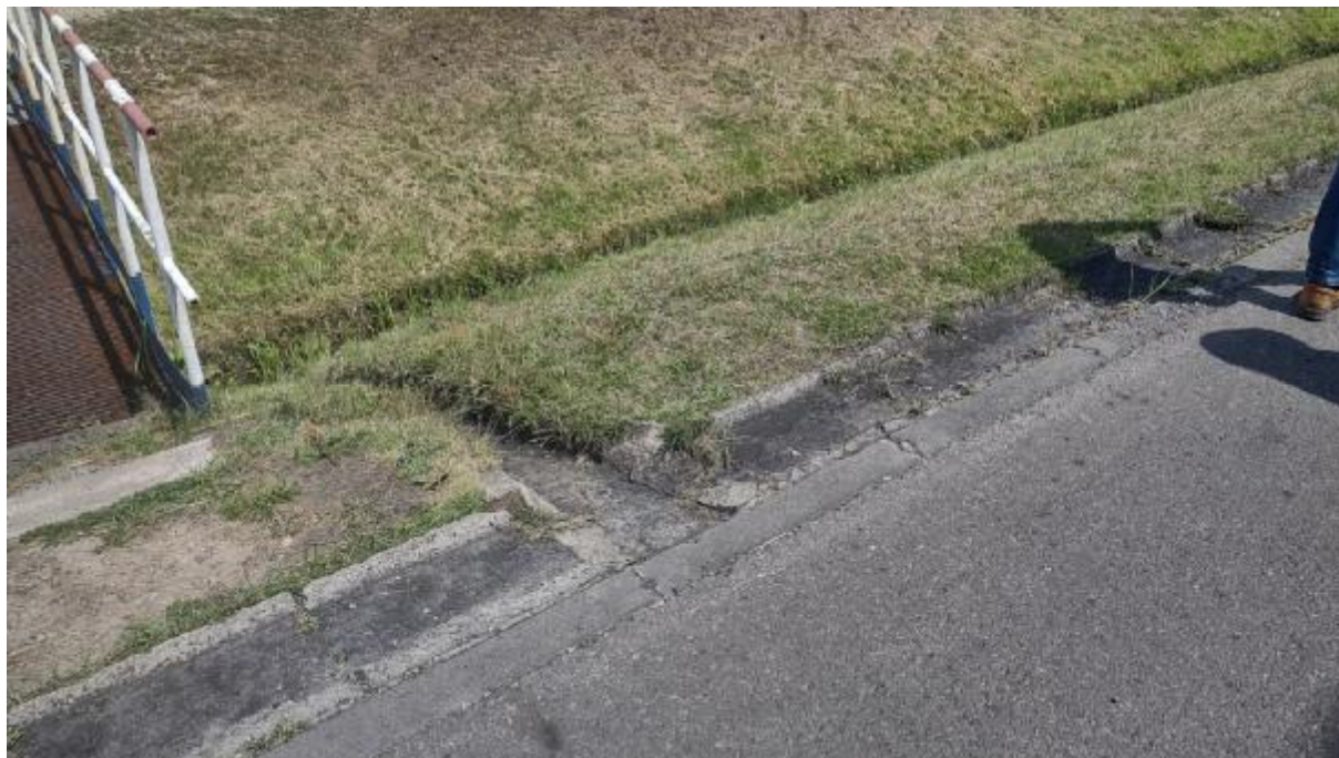
Fotografia nr 2 Rów – odbiornik wód deszczowych spływających z terenu terminala przeładunkowego
