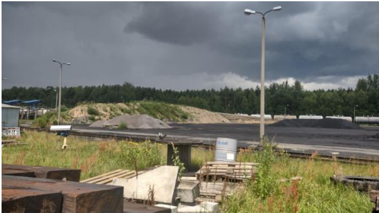
Fot. 3. Widok na teren inwestycji od zachodniej strony .
