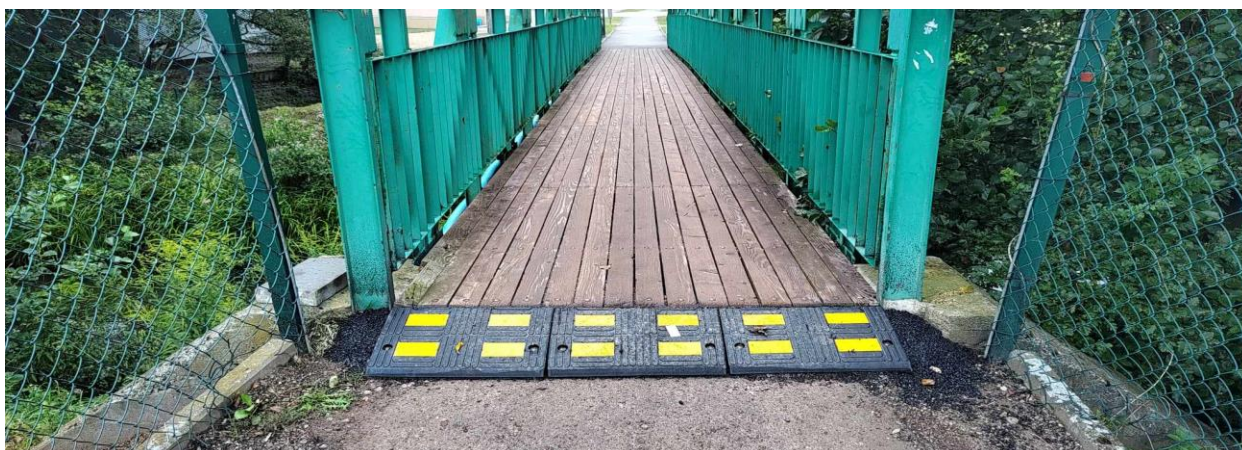
Rysunek 15. Montaż najazdów przy kładce ul. Młyńska
