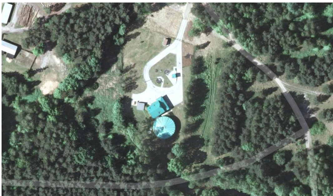
Rysunek 7. Oczyszczalnia przy ul. Burki
