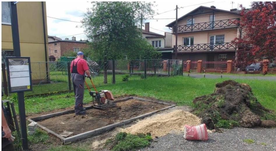
Rysunek 15. Montaż najazdów przy kładce ul. Młyńska
