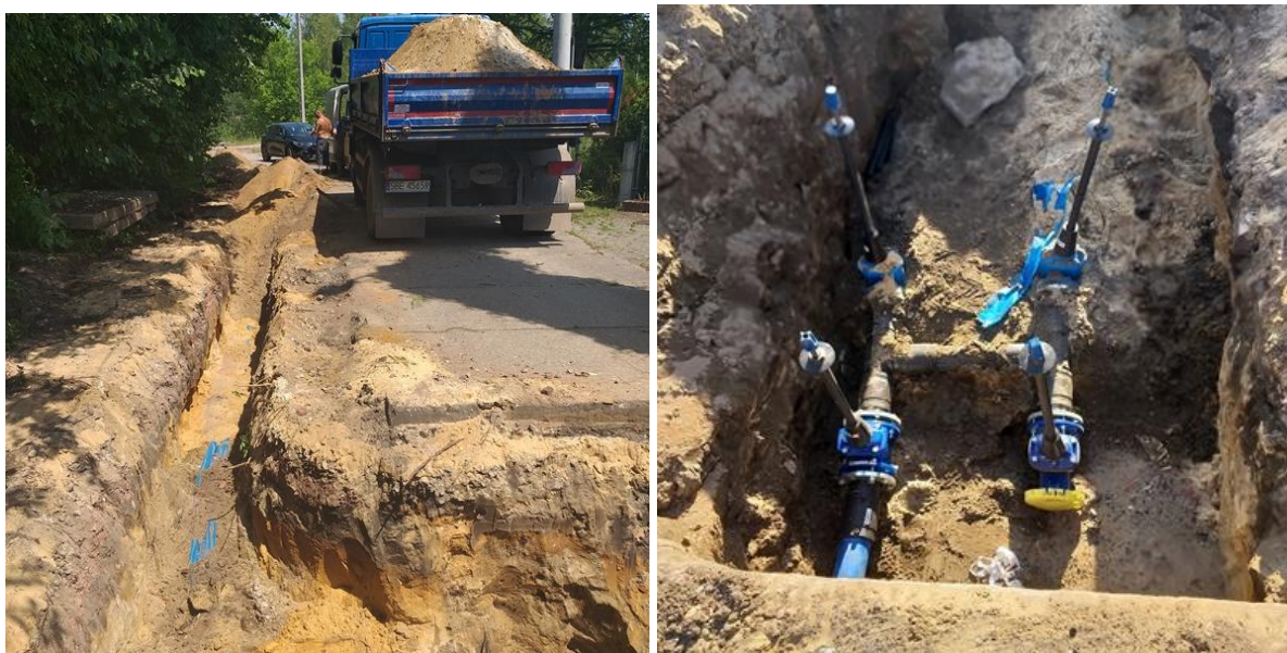
Zdj. 13. Wymieniony odcinek sieci wodociągowej w ciągu ulicy Jodłowej (źródło: www.slawkow.pl ).
