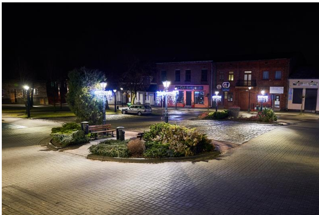
Zdj. 5. Rynek – wymienione oświetlenie uliczne (źródło: https://slawkow.pl ).
