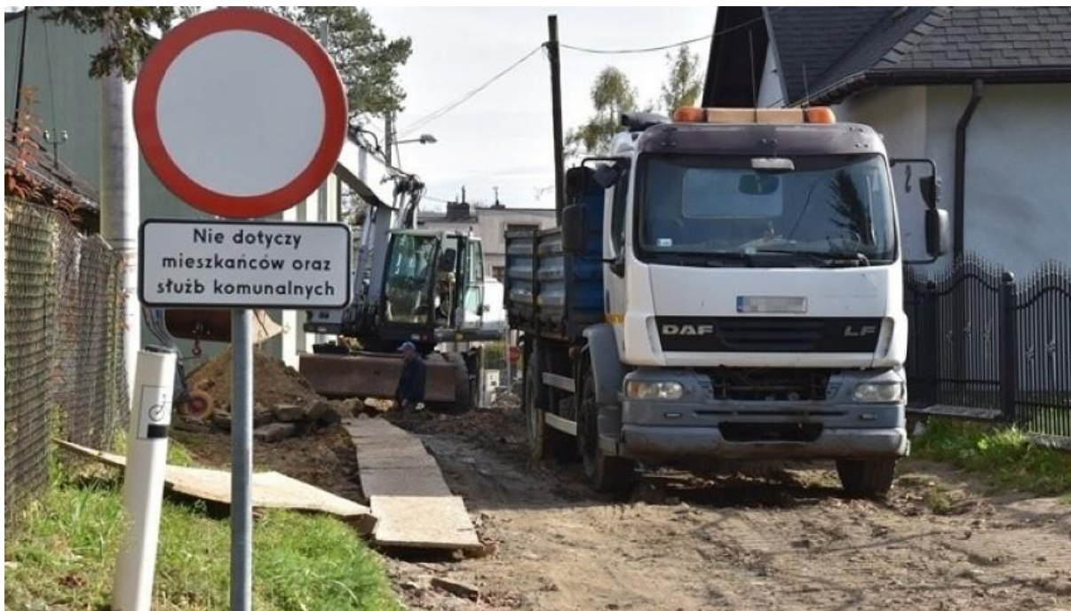
Zdj. 12. Prace związane z przebudową ulicy Zakościelnej – budowa sieci kanalizacyjnej i wodociągowej (źródło: www.slawkow.pl ).
