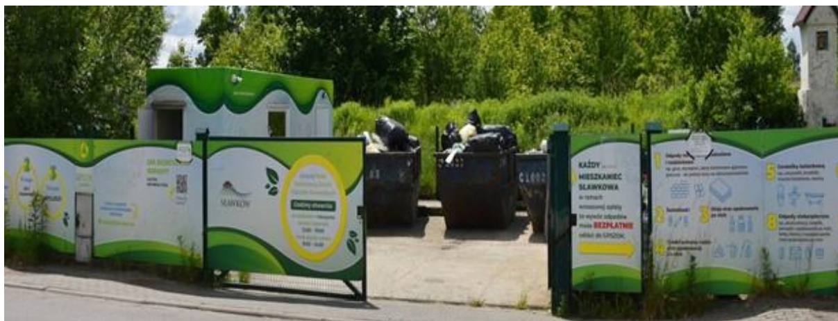
Zdj. 17. Zmodernizowany Gminny Punkt Selektywnej Zbiórki Odpadów Komunalnych (źródło: www.slawkow.pl ).
