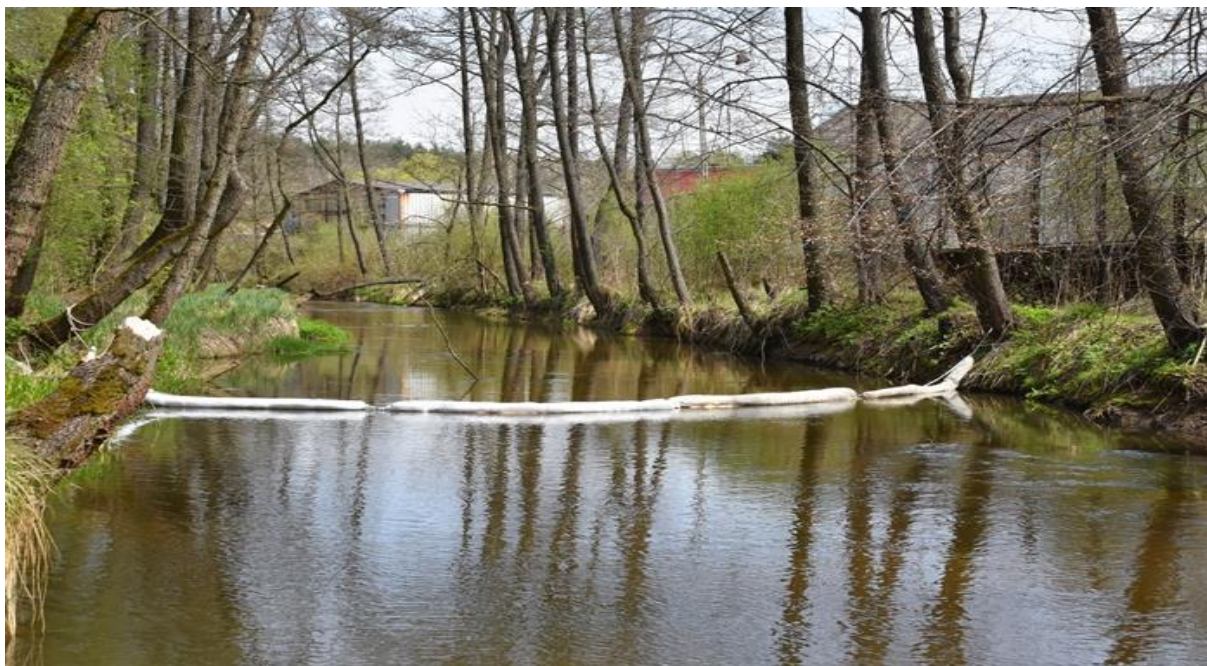
Zdj. 9. Rękaw sorpcyjny założony na Białej Przemszy w celu ograniczenia rozprzestrzeniania się substancji ropopochodnych (źródło: https://slawkow.pl ).
