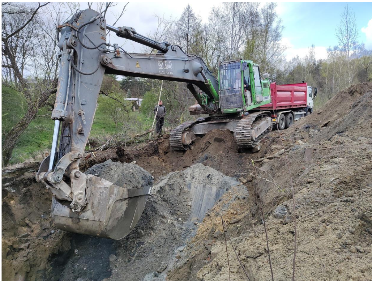
Zdj. 10. Wydobywanie zanieczyszczonej substancjami ropopochodnymi ziemi (foto. M. Pięta).
