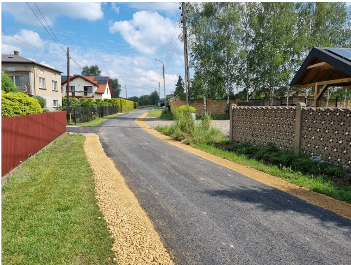
Zdj. 7. Nowa nakładka asfaltowa ul. Cechowa (źródło: https://slawkow.pl ).
