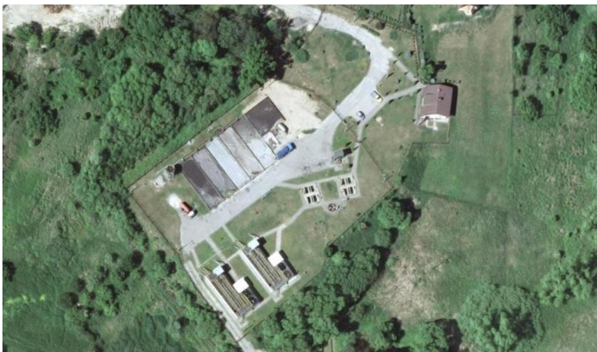
Zdj. 11. Stara oczyszczalnia ścieków Sławków ul. Browarna.
