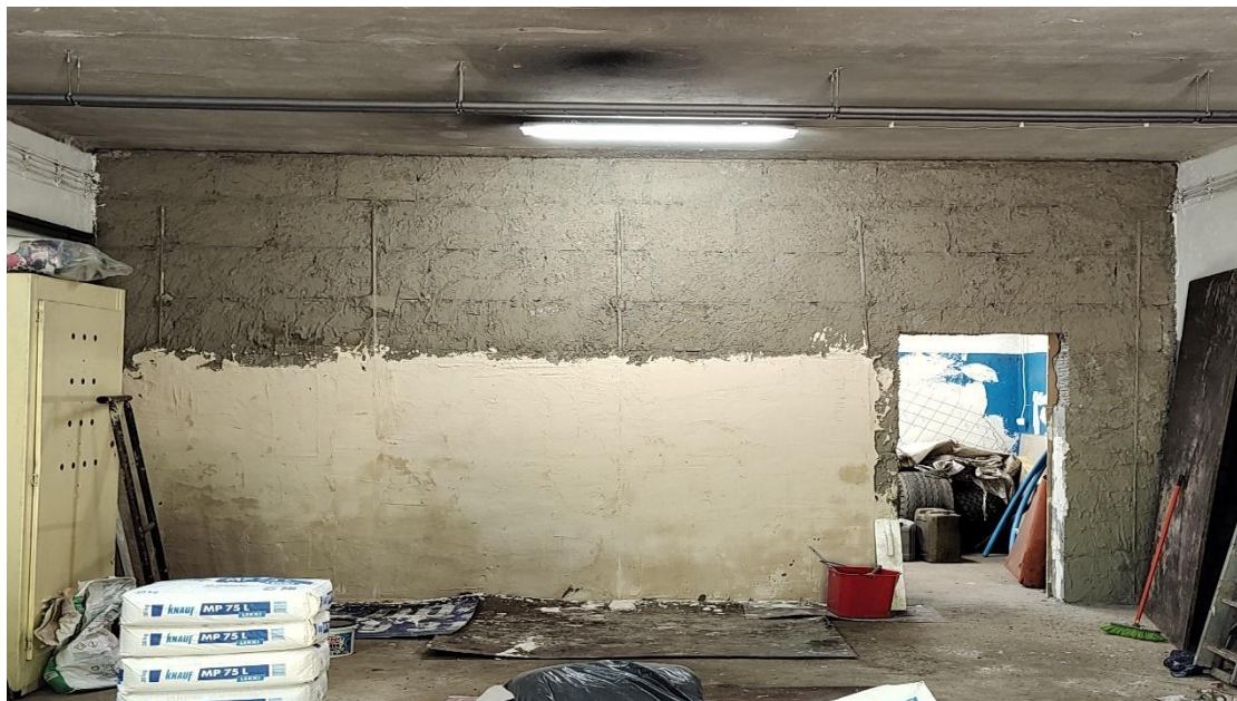
Rysunek 13. Remont pomieszczenia warsztatu
