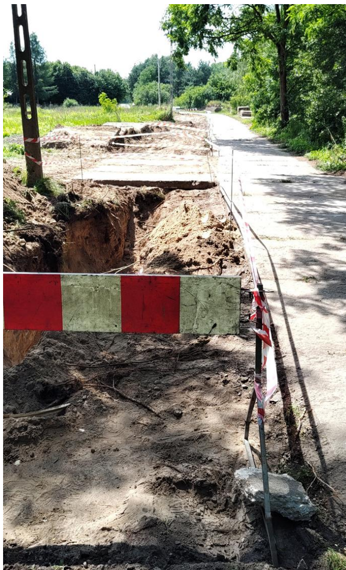
Rysunek 6. Prace związane z wymianą wodociągu w ul. Jodłowej
