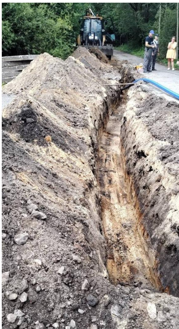
Rysunek 6. Prace związane z wymianą wodociągu w ul. Jodłowej
