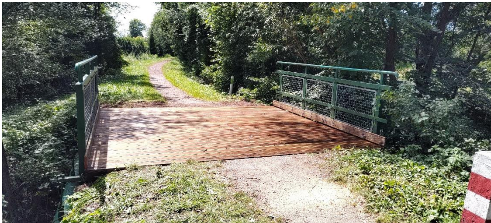
Rysunek 16. Wymiana poszycia na moście ul. Walcownia w ciągu ścieżki rowerowej
