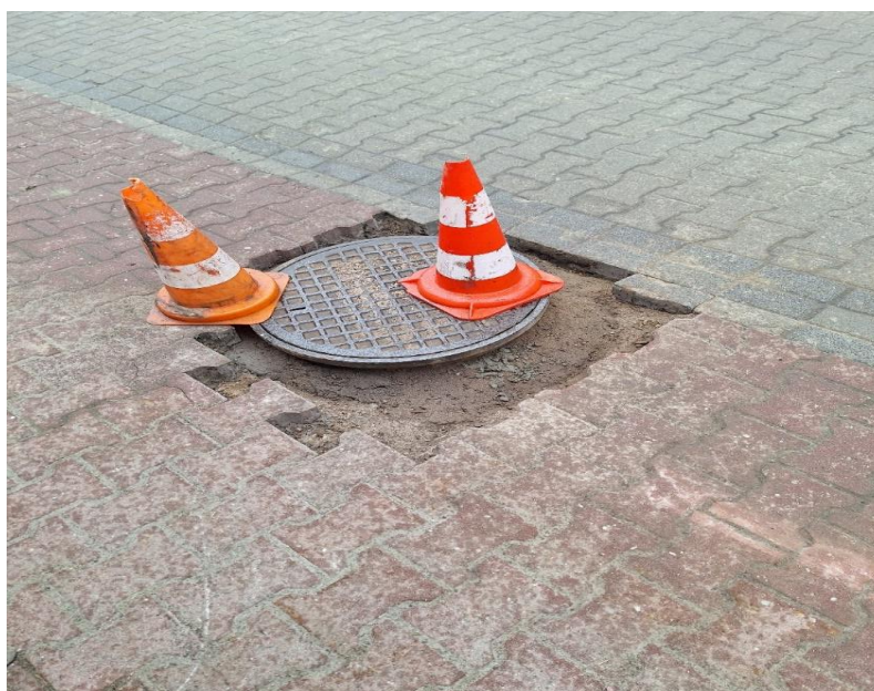
Rysunek 12. Naprawa studzienki kanalizacyjnej
