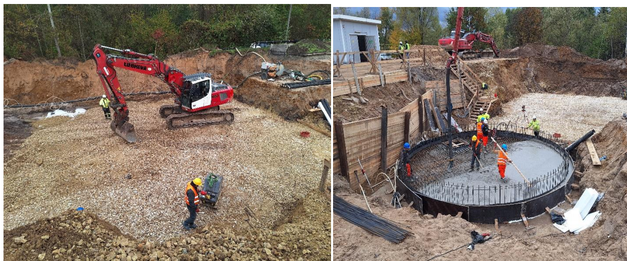
Rysunek 21. Budowa oczyszczalni ścieków ul. Browarna
