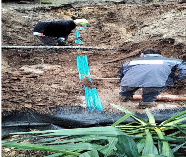
Rysunek 7. Prace związane z wymianą wodociągu w ul. PCK
